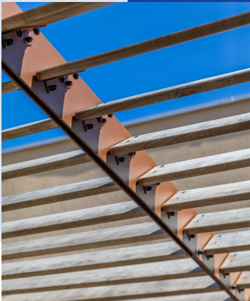
Pose horizontale entre console
