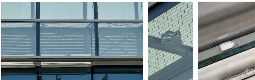
Les 6 ouvrants (ventelles Luxlam) sont pilotés par 12 capteurs qui analysent la température et l'ensoleillement et optimisent la ventilation naturelle pour aérer les locaux lorsque les températures grimpent au-delà du niveau défini, tandis que 2 d'entre eux permettent la récupération d'air chaud dans la double peau (jusqu'à 35/40 degrés en hiver) pour la réinjecter dans la CTA lorsqu'il fait plus frais à l'extérieur.
