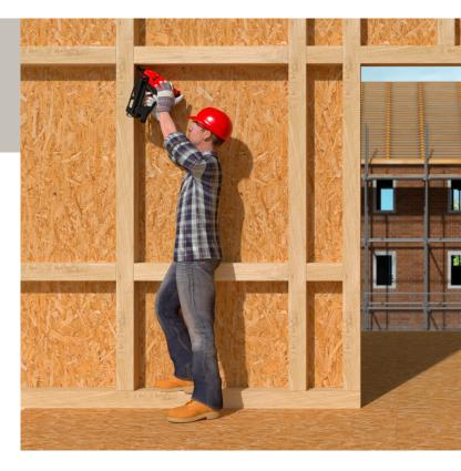
bouton de butée **de la profondeur** d'ancrage pour des fixations à fleur ou à cœur, et nécessite peu d'entretien, avec des intervalles de maintenance toutes les **20 000 fixations**.
