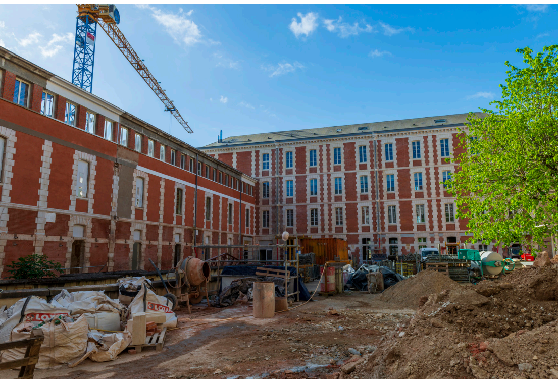
Travaux au Collège Henri IV de Poitiers (janvier 2024).
