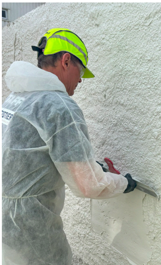
Dressage de l'enduit de finition NOVASKIN® Finish.
