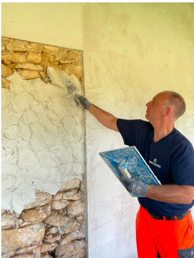
Tenue et aspect du sous-enduit NOVASKIN® Thermo Plus.
