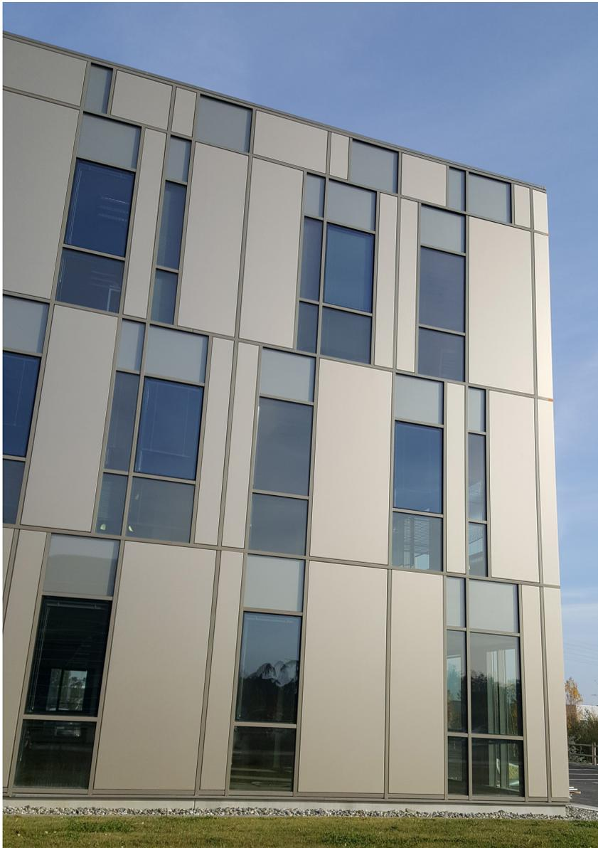
Prêt à poser, avec une feuillure à partir de 32 mm, les dimensions sur mesure de **Nuancéa** (de 200 x 300 mm jusqu'à 1800 x 3500 mm), son épaisseur (de 56 mm à 150 mm) permettent une intégration harmonieuse et performante selon les besoins spécifiques de chaque ouvrage.
