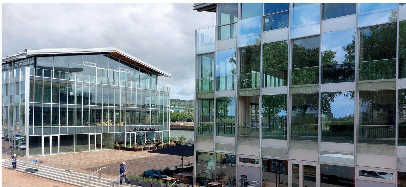
Hangar 105 | Rouen (76) : 250 m<sup>2</sup> de panneaux Nuancéa de type shadow box et 190 m<sup>2</sup> de panneaux de façade Glacéa en glace émaillée trempée viennent habiller les façades extérieures et les patios intérieurs.
