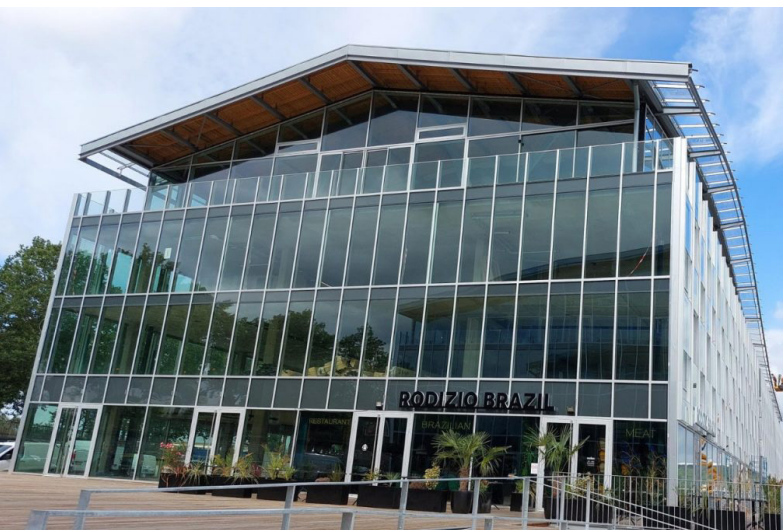
EA DÉCO avec Nuancéa. Hangar 105 Rouen : Maître d'œuvre : Marc Mimram Architecture et ingénierie Maître d'ouvrage : La Métropolitaine.
