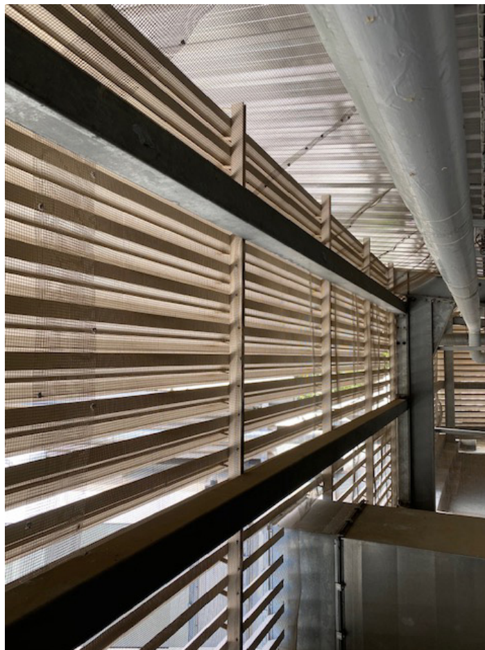
Centre Hospitalier de Mayotte. © Bardage à ventelles FAÇAD'LIGNE de TELLIER BRISE-SOLEIL
