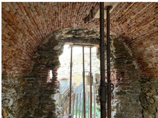
Le plus gros enjeu du chantier a consisté à la reprise des chaînes d'angles et à la déconstruction puis à la reconstruction de certaines parties de l'édifice qui présentaient des fissures trop importantes et/ou afin de remplacer des pierres trop érodées (jusqu'à 20 cm de perte d'épaisseur).
