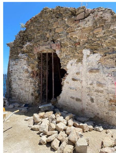
Si l'ensemble du site a nécessité de lourds travaux de rénovation, la poudrière, bâtiment particulièrement dégradé, a fait l'objet d'une attention particulière. Une partie de ses murs en moellons ont été restaurés ou remontés et son plafond voûté composé de briques, a également été rénové de la même façon.
