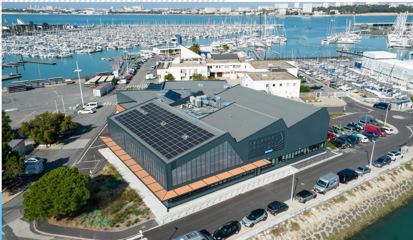
Les brise-soleil architecturaux AZUR de TELLIER BRISE-SOLEIL : une solution d'ombrage passive mis en œuvre sur les façades du Tribord Sailing Lab à LA ROCHELLE (17). © TELLIER BRISE-SOLEIL
