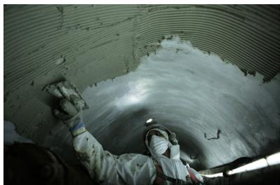
1ère passe de **LANKOSTRUCTURE CARBOGRID (52 et 53)** sur couche de propreté.
