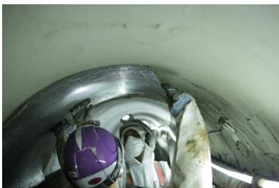
Pose de la grille en carbone **32 LANKOSTRUCTURE CARBOGRID**.
