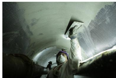
Marouflage et enrobage de la grille carbone avec **LANKOSTRUCTURE CARBOGRID (52 et 53)**.
