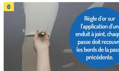
Règle d'or sur l'application d'un enduit à joint, chaque passe doit recouvrir les bords de la passe précédente.
