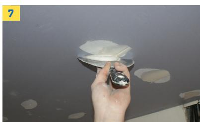
Reboucher les têtes de vis lors de la première et seconde passe en veillant à ne pas laisser de surépaisseur. Garnissez puis raclez les bords. L'enduit ne doit pas présenter de surépaisseur.
