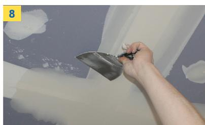
N'hésitez pas à passer votre couteau sur les bords de l'enduit fraîchement déposé pour retirer l'excédent de matière. Faites un geste semi circulaire pour les joints perpendiculaire. Cette technique assure également un parfait lissage des bords.
