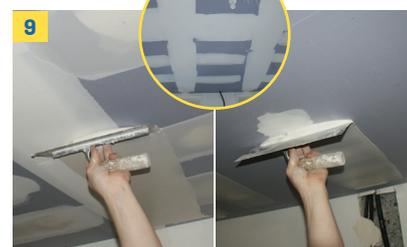
Pour la troisième et dernière étape - passe de finition - utiliser une lisseuse (ou une platoir) et faites-la dépasser de l'équivalent de la longueur de la lisseuse de chaque côté des bords amincis. Faites de même avec les vis. Garnissez chacune des rangées de vis à l'aide du même outil. Après séchage complet, faites un très léger ponçage de votre plafond ou de vos murs avant la mise en peinture.
