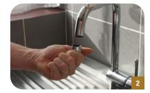
Dévissez le mousseur présent sur le bec de votre robinet. Si vous ne parvenez pas à le dévisser à la main, utilisez une clé à molette. Placez l'outil sur les deux empreintes plates présentes sur la bague du mousseur prévues à cet effet (vissage/dévissage) pour une meilleure prise et pour éviter de rayer le mousseur.
