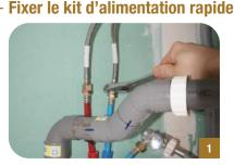
Coupez l'alimentation de votre évier et ouvrez le robinet afin de vidanger totalement l'arrivée d'eau froide. A l'aide de la clé à molette, dévissez le flexible, puis retirez-le du tube en PER, comme ici, en cuivre ou en multicouche selon votre type d'installation.
