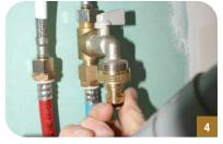
Terminez votre installation en vissant le raccord rapide en laiton sur le bec du robinet du kit. Vérifiez que la vanne d'arrêt soit bien en position "fermée" (volant orienté perpendiculairement au robinet) et remettez votre circuit
