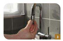
Une fois le robinet libéré de son mousseur, présentez le raccord rapide en laiton nickelé face au filetage du nez du robinet. Le raccord étant équipé d'un joint, vissez simplement ce dernier sur le robinet en veillant à ne pas trop compresser le joint.
