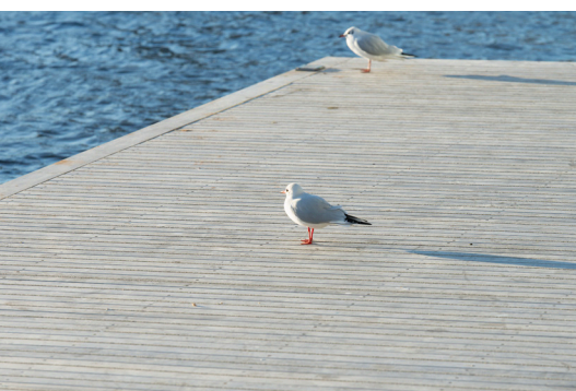
Platelage réalisé en lames ACCOYA avec systèmes de fixations apparentes.
